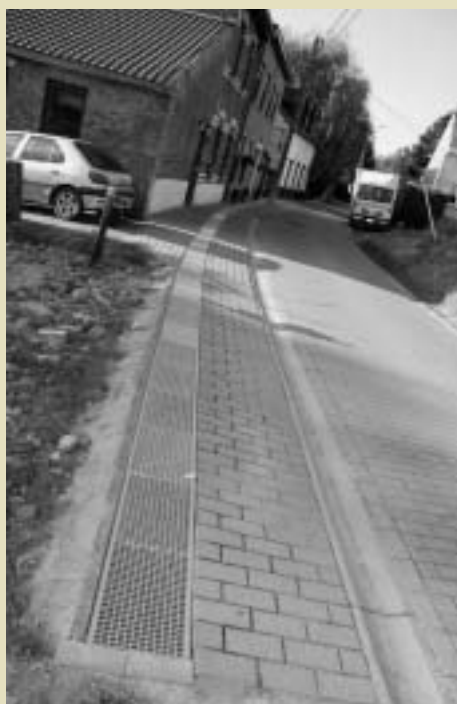
Zwartenbroek aanleg afwatering tegen overstromingsgevaar
