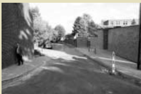
Carnaalstraat / Eizeringen laatste werkzaamheden
